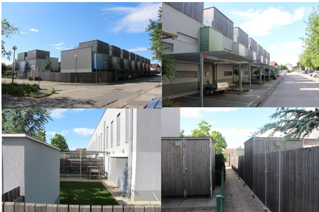
Slika 23 Pogled na vrstne hiše in dvojčke Pobrežje
