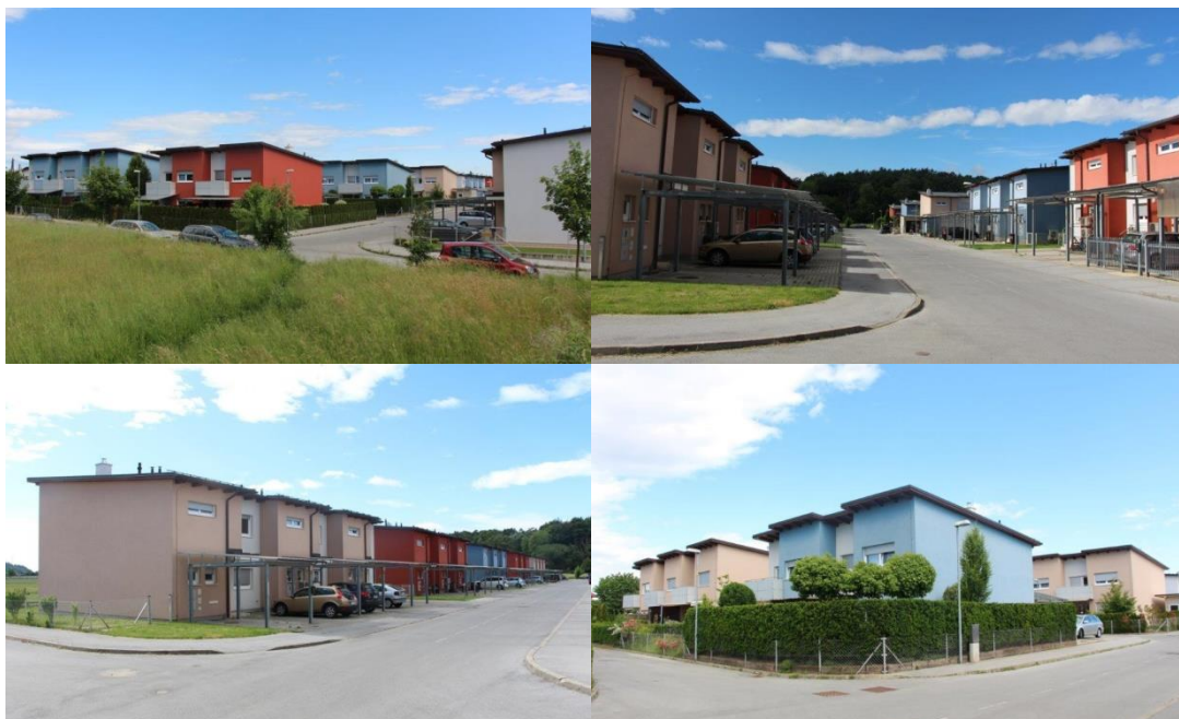
Slika 27 Pogled na naselje hiš Brezje
