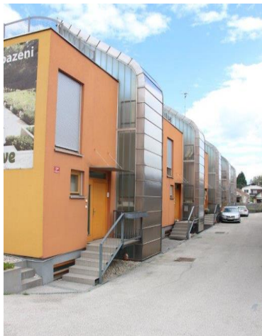
Slika 21 Pogled na vrstne hiše Strelška cesta
