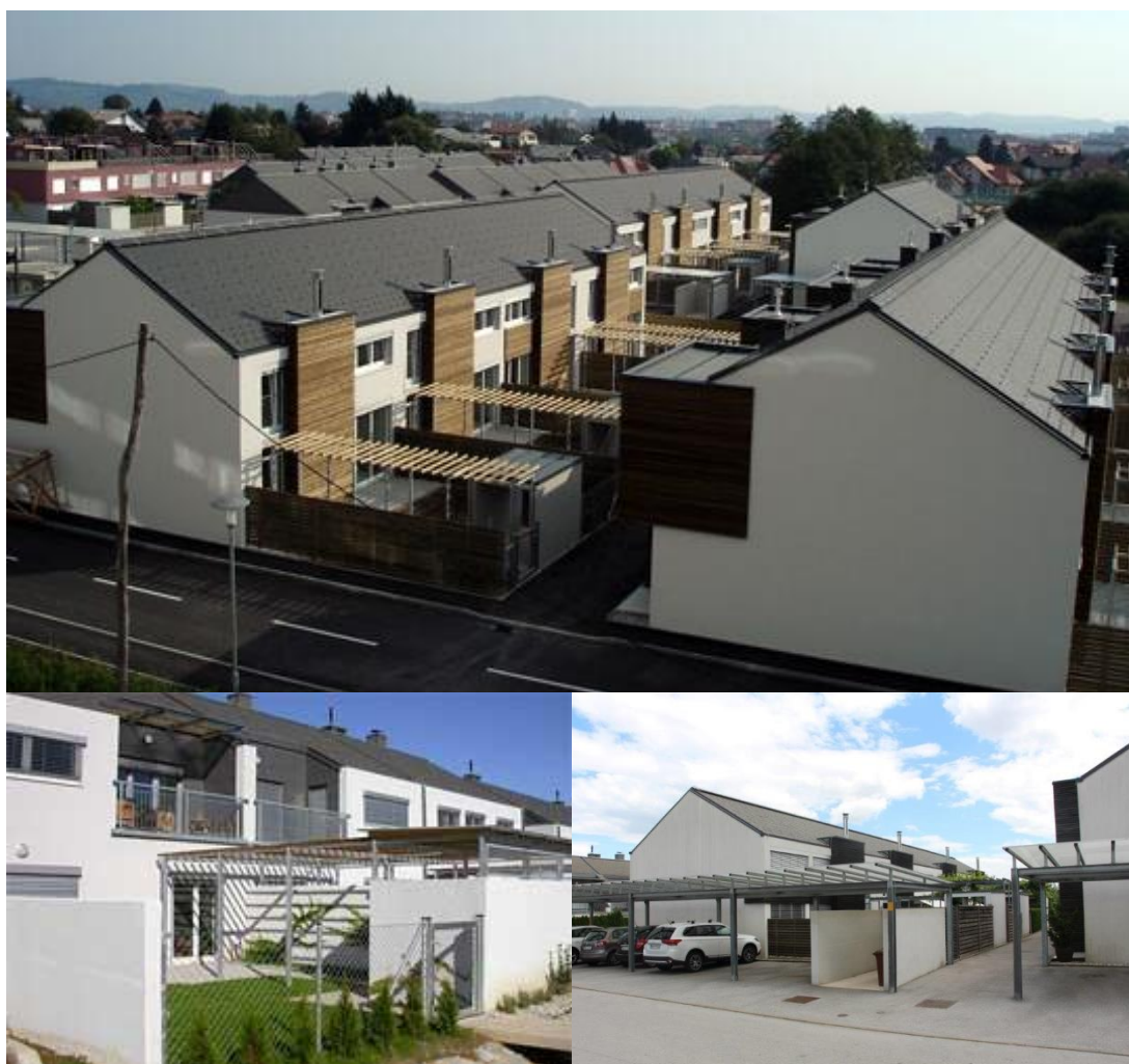
Slika 15 Pogled na naselje hiš pod Pohorjem 1 – vrstne hiše
