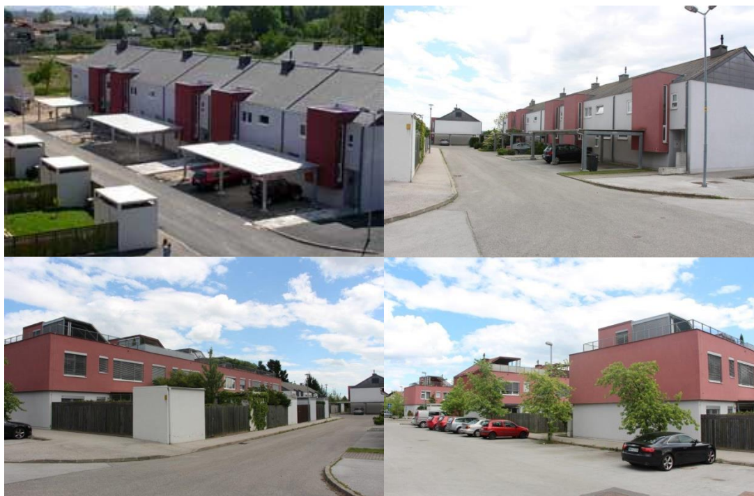
Slika 16 Pogled na naselje hiš pod Pohorjem 1 – hiše v vrsti
