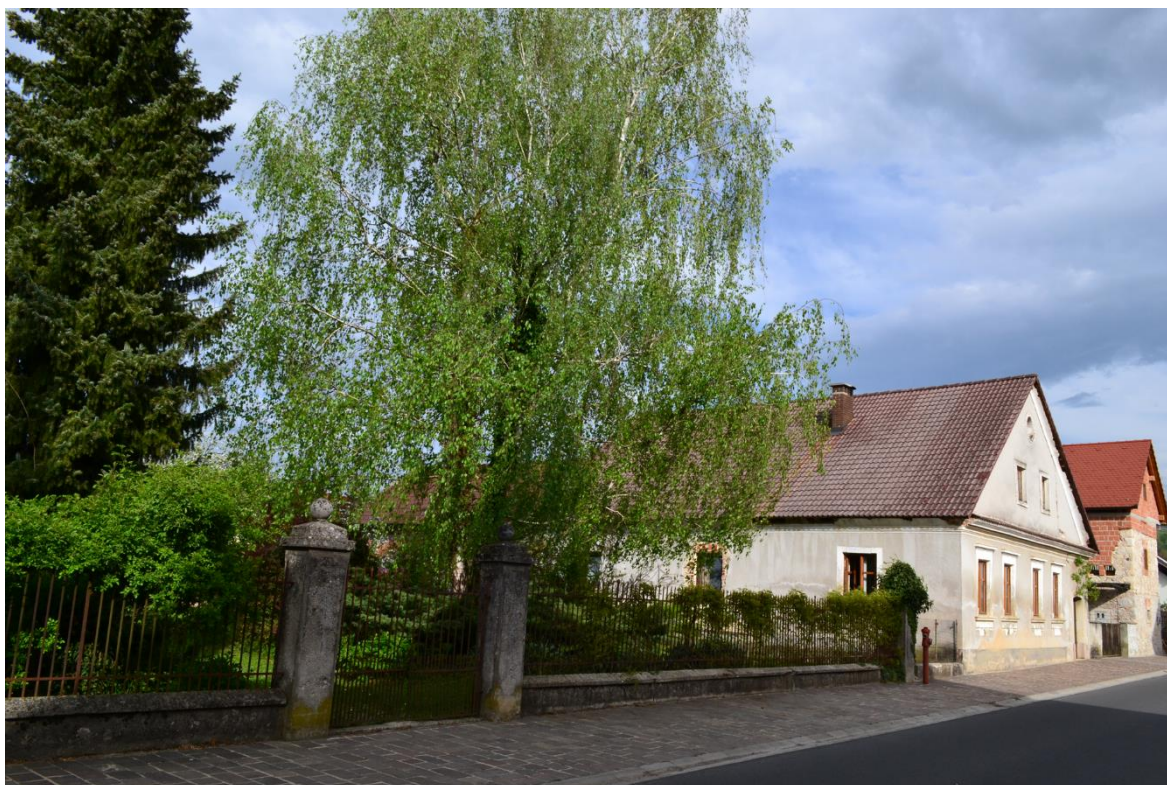
Slika 5: Primer kmečkega tipa, ki je s krajšim hišnim pročeljem obrnjena na ulico, hiša na Oražnovi ulici št. 18.
