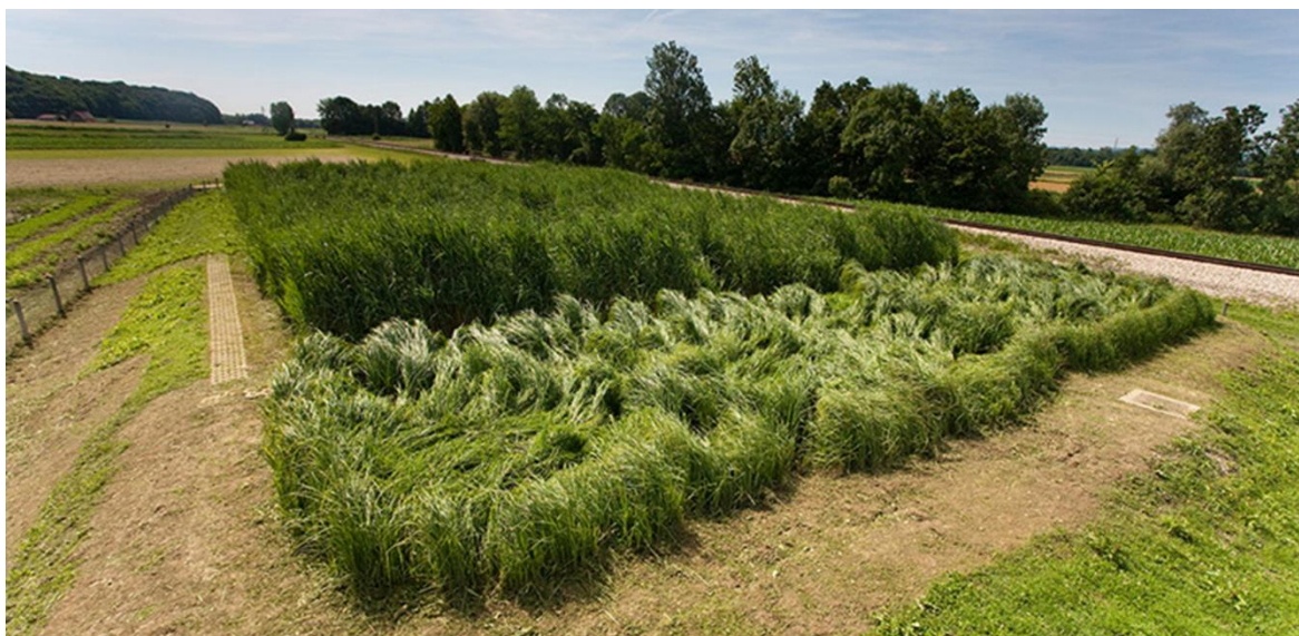
Slika 43: Rastlinska čistilna naprava v Veliki Nedelji (Rastlinska čistilna naprava LIMNOWET®, 2010).
