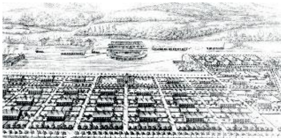
Slika 33: Prostorska kakovost železničarske kolonije v Mariboru se izraža preko oblikovne in urbanistične razsežnosti, ki se zrcalita v: tlorisni mreži, vrtovih 49 okoli stavb, arhitekturi, drevoredih in splošnem vzdušju (Zgodovina ..., 2005).
