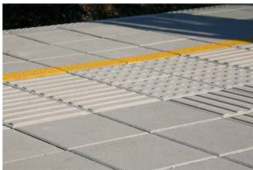
Slika 38: Tip taktilnih plošč, opozorilna–mehurčkasta, vodilna–rebrasta, kontrastna–rumena (Stavbar Igm d. o. o. 2016)
