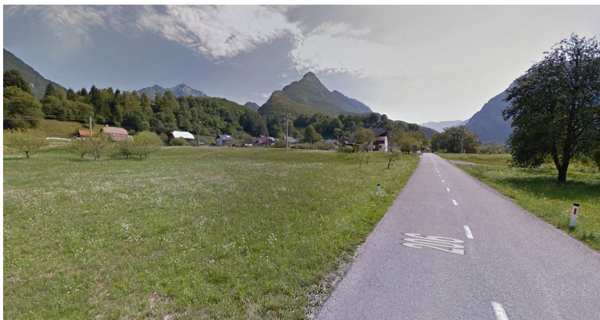
Slika 46: Pogled proti Kal – Koritnici z regionalne ceste danes (Google street ..., 2016)
