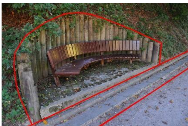
Slika 35: Peščena pot skozi gozd je v dobrem stanju, vendar je betonski drenažni kanal zaradi erozije poti delno nefunkcionalen, prav tako palisadna ograja iz lesenih kolov prepereva in se lomi
