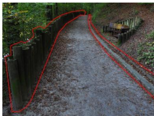
Slika 35: Peščena pot skozi gozd je v dobrem stanju, vendar je betonski drenažni kanal zaradi erozije poti delno nefunkcionalen, prav tako palisadna ograja iz lesenih kolov prepereva in se lomi
