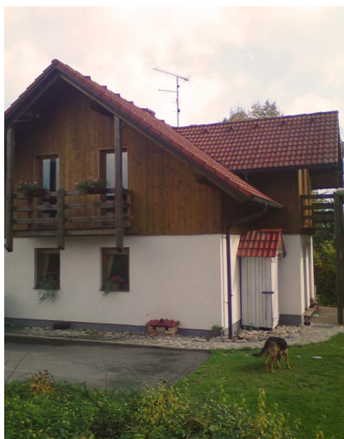
Slika 8: Kot na prejšnji fotografiji, pogled s severne strani (Kočevje, ulica Veronike Deseniške)
