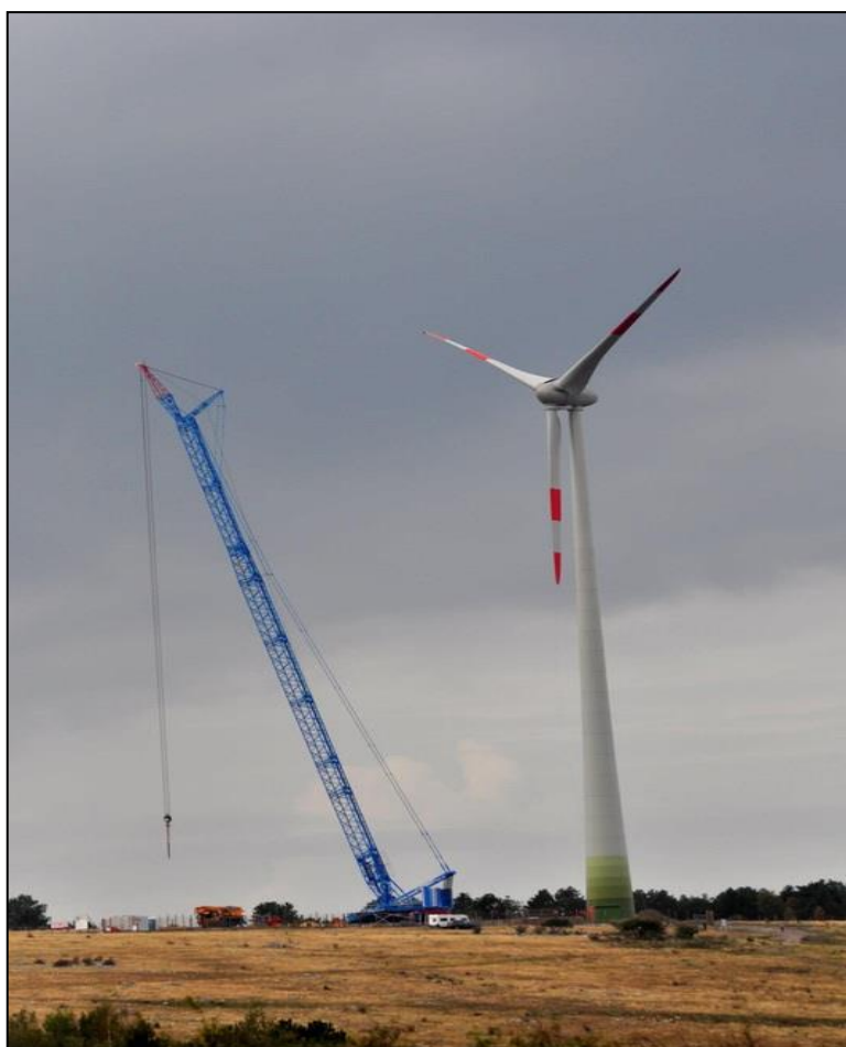
Slika 7: Gradnja vetrne elektrarne v Dolenji vasi pri Senožečah (Volk, 3. 10. 2013)
