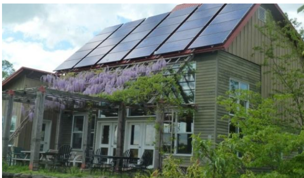
Slika 3: Ekološka vas Ithaca – hiša s sončnimi kolektorji na strehi in pergolo na južni fasadi (Ecovillage Ithaca, 2013)
