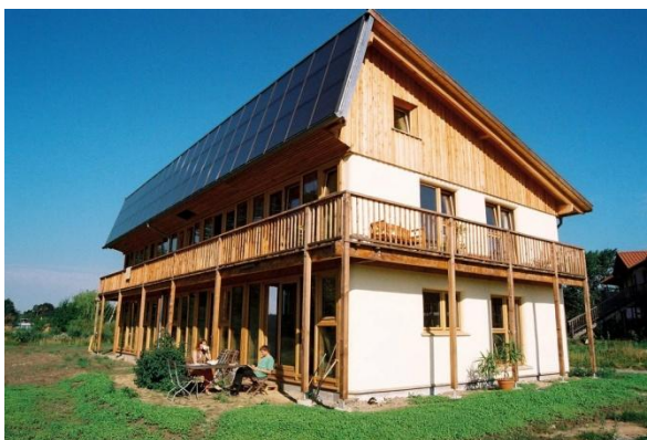
Slika 10: Ekovas Sieben Linden - večstanovanjska hiša iz slame s sončnimi kolektorji na strehi (Sieben ..., 2015)
