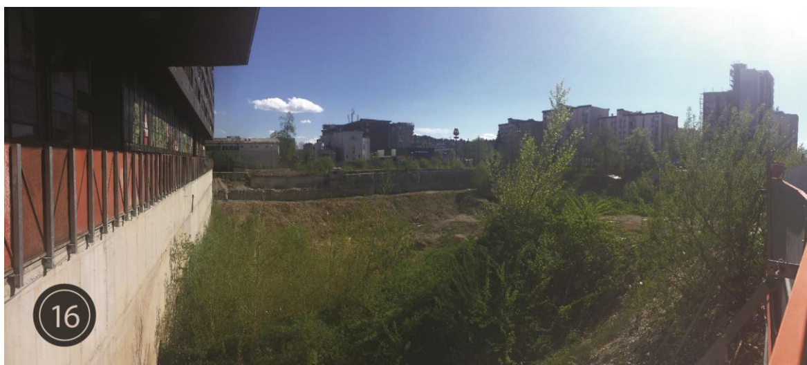
Slika 62: Na območju predvidenega hotela Celovski dvor se trenutno nahaja zgolj gradbena jama ter odlagališče odpadkov (marec, 2016).
