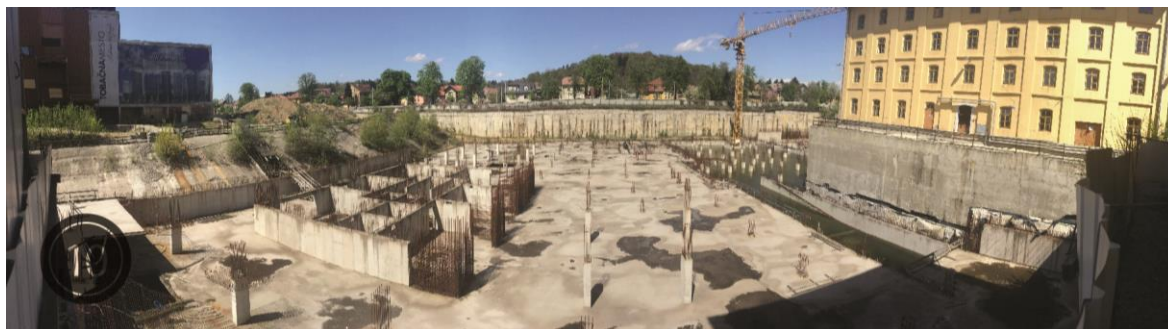
Slika 50: Pogled na območje gradbene jame, kjer naj bi stale prve stanovanjske stolpnice ter javna in zasebna garažna hiša (april, 2016).
