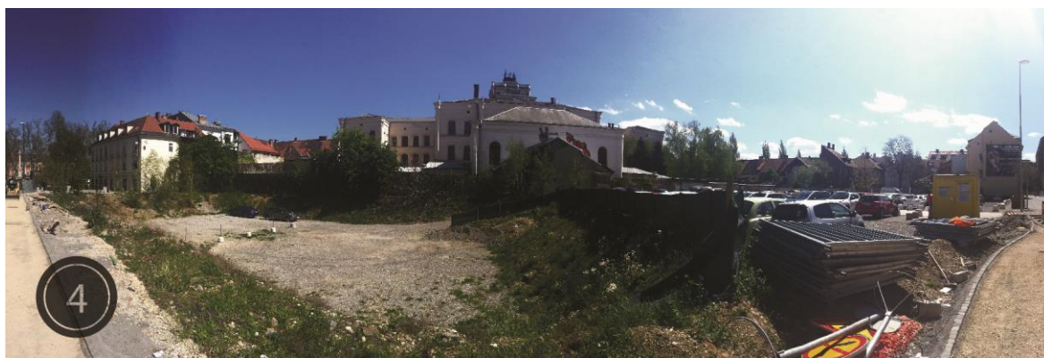
Slika 37: Tudi v delno zasuti gradbeni jami je sedaj urejeno začasno parkirišče (april, 2016).
