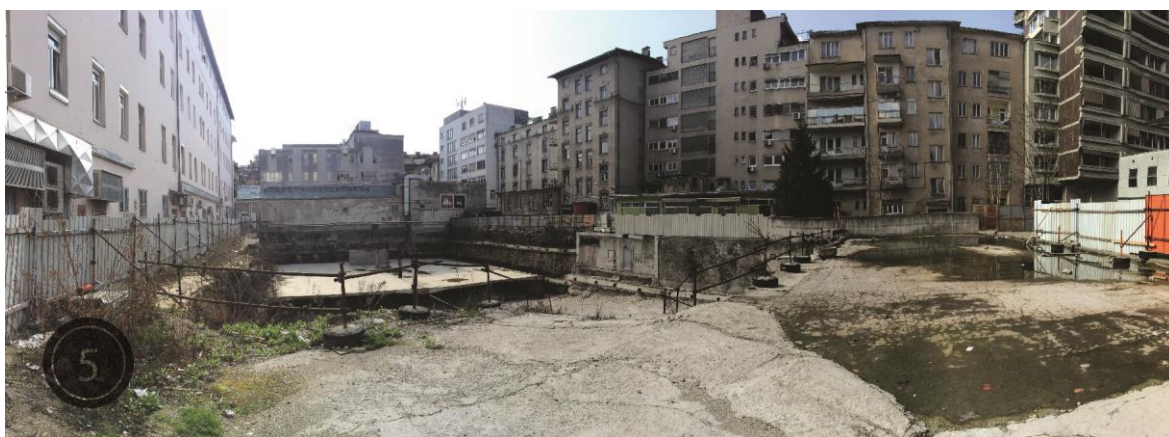
Slika 39: Dodatni finančni stroški so se pojavili ob nevarnosti posedanja sosednjih objektov zaradi globoke gradbene jame, kjer naj bi stala garažna hiša Kozolec II (marec, 2016).
