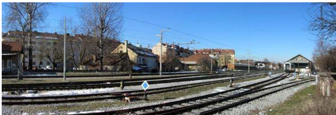
Slika 27: Pogled proti Šiški – na fotografiji je moč opaziti razdvojenost Šiške in Bežigrada. Prehajanje čez progo je v tem delu bolj nevarno saj je nepregledno in nasičeno s tirnimi napravami. Po trasi železnice bi lahko potekala povezovalna pot in zelene površine (10)
