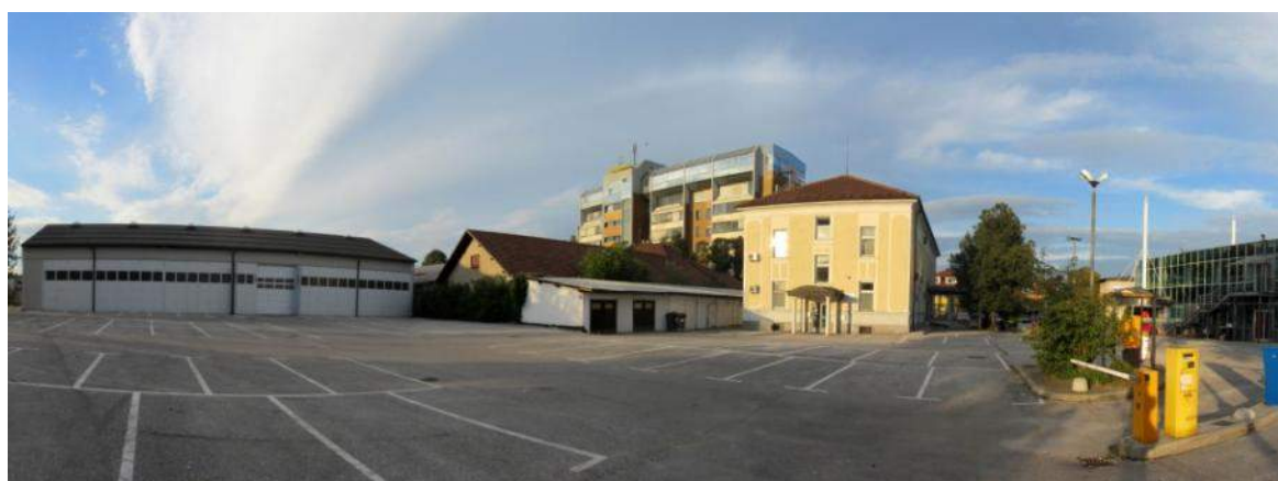
Slika 23: Proizvodni objekti za storitveno cono ob Parmovi – v zaledju storitvene cone se nahajajo velike površine s proizvodnimi objekti. Nekateri objekti so primerni za odstranitev (6)
