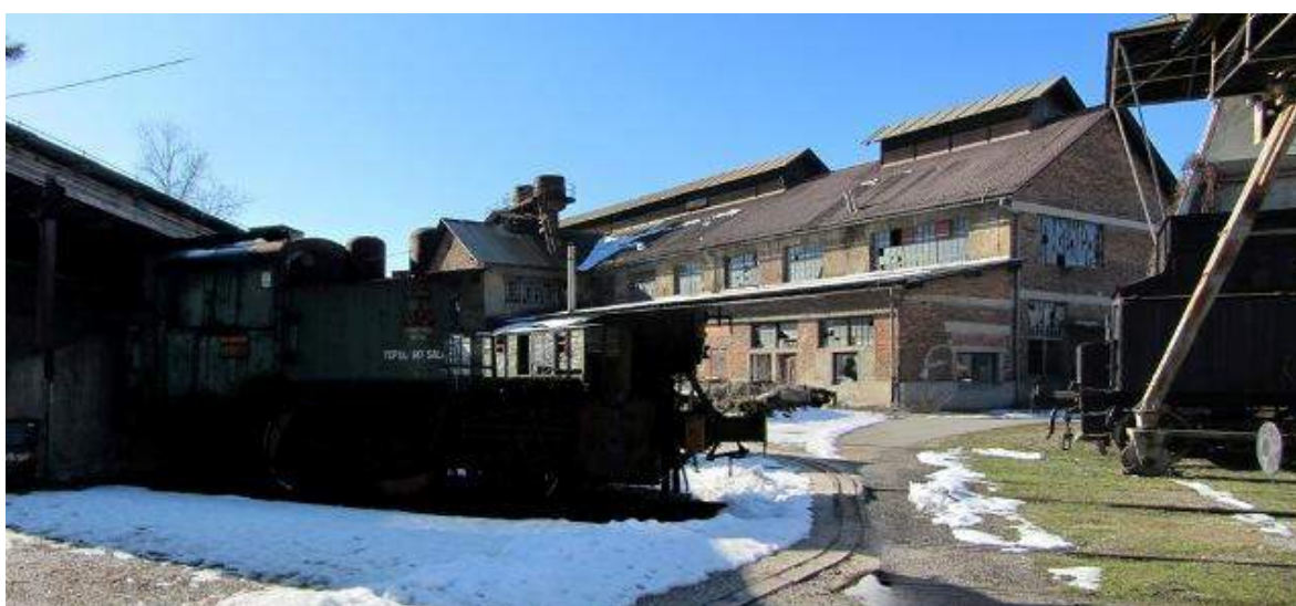
Slika 25: Stara livarna – pomemben zgodovinski objekt, ki je potreben celovite prenove. Zadrževanje v tem objektu ni dovoljeno in je nevarno. Predstavlja potencial za preureditev in razširitev muzejske zbirke (8)
