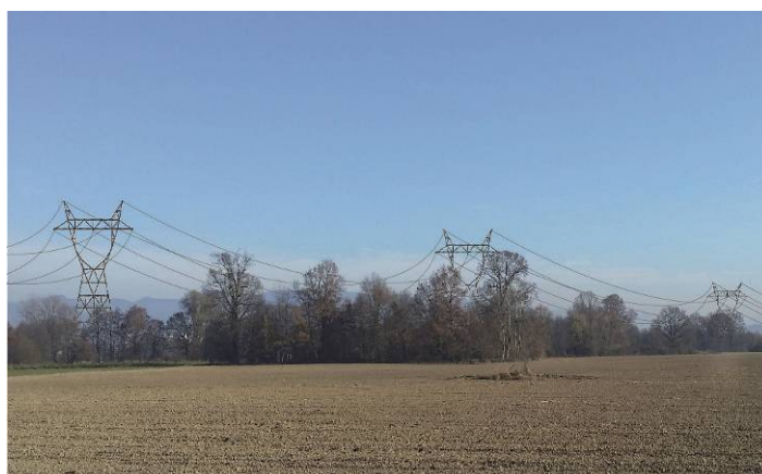
Slika 14: Možna postavitev daljnovoda 2
