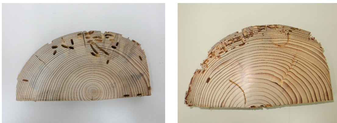
Slika 26: Prečni prerez odvzetih stropnikov s stropne konstrukcije z značilnimi izletnimi odprtinami hišnega kozlička v predelu beljave (levo in desno).
