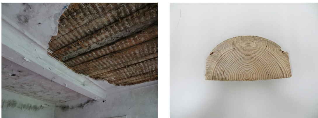
Slika 25: Izgled stropne konstrukcije v Graščini Preddvor (levo). Prečni prerez smrekovega stropnika odvzetega v Graščini Preddvor (desno).
