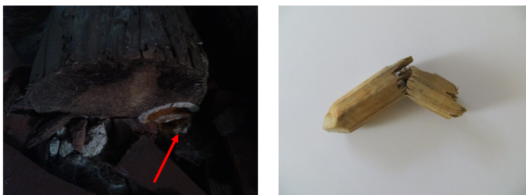
Slika 2: Okužen stropnik s sivo hišno gobo (levo). Hrastov mozni (desno).
