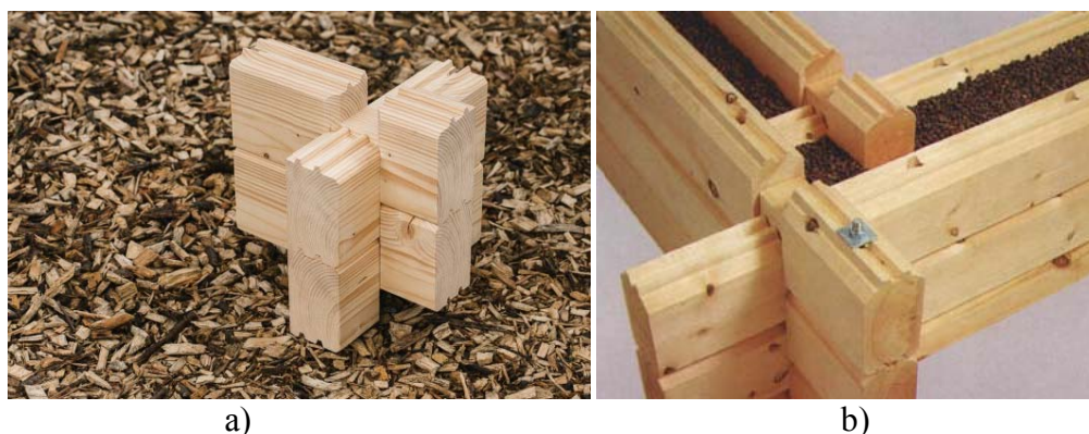
Slika 3: a): Primer križnega spoja lesenih klad oz. brun (Talg, 2014) / b): Dvojna stena z vmesno izolacijo (Seinit, 2014)
