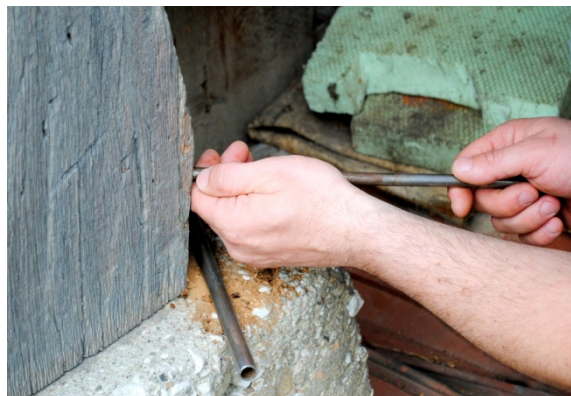
Slika 12: Odstranitev izvrtka s posebnim orodjem.
