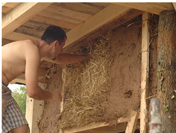
Slika 3: Slama kot polnilo in izolacija (vir: Petrivčič, 2007)
