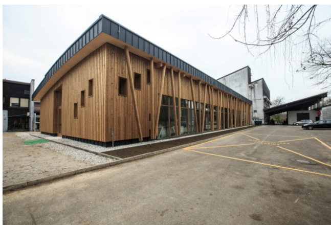
Slika 2: Fasada in okna iz termično modificiranega lesa na prizidku Oddelka za lesarstvo (Oddelek za lesarstvo, 2015).
