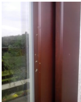
Slika 1: Primer smoljenja iz smrekovega okenskega profila.
