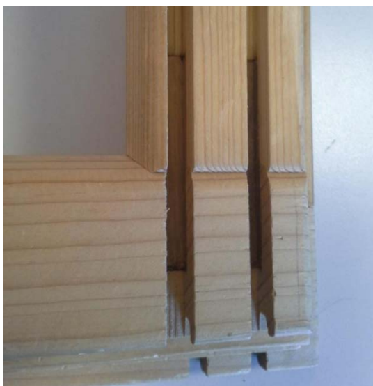
Slika 1: Prerez okna z mozničeno vezjo (Arhiv M SORA, 2015)
