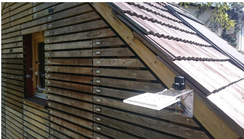
Slika 13: Prikaz izvedbe fasade in merilec zadrževanja kondenza na vodoravni površini (Avtor: Nejc Zakrajšek)
