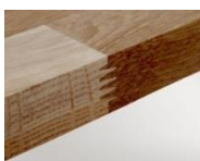
Slika 8: Dolžinski spoj pri dolžinsko-širinsko lepljeni plošči (Keilzinken...,2016)
