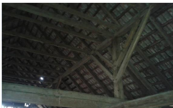
Slika 3: Strešna konstrukcija – leva
