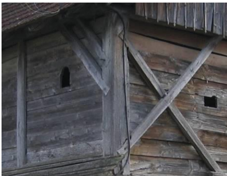
Slika 5: Nosilni steber (ražanec) – leva
