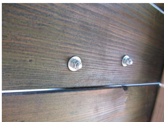
Slika 12: Pritrditev oprimkov na obstoječem igralu
