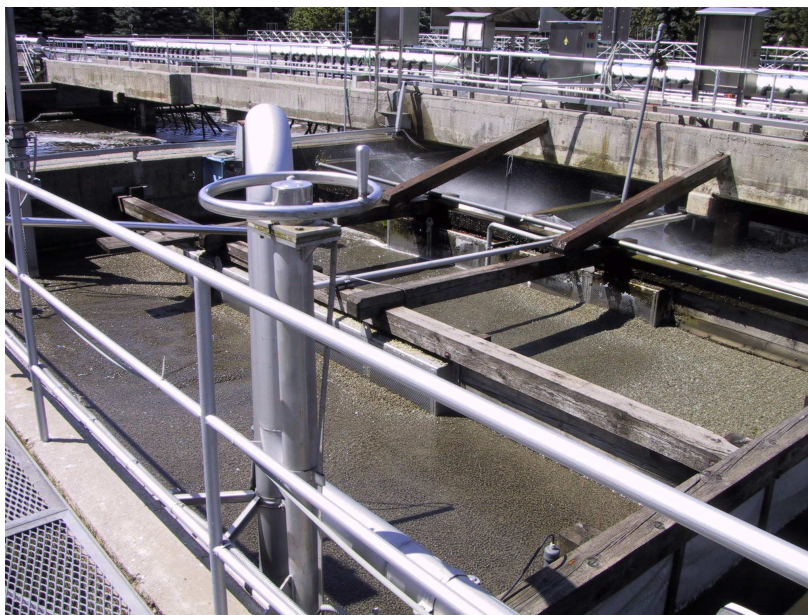
Slika 8: Uporaba plavajočih nosilcev Kaldnes K1 kot proces MBBR v bazenu ČČN DK
