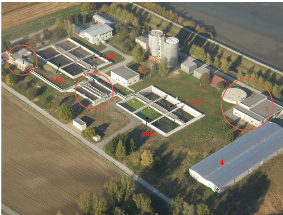
Slika 2: Panoramska fotografija CČN Ptuj (Gojkošek, 2012): (1) mehanski del čiščenja z grobimi in finimi grabljami, (2) pred-denitrifikacijska bazena z vgrajenim maščobnikom in peskolovom, (3) gravitacijski zgoščevalnik in prostor s centrifugama, (4) sušilne hale.
