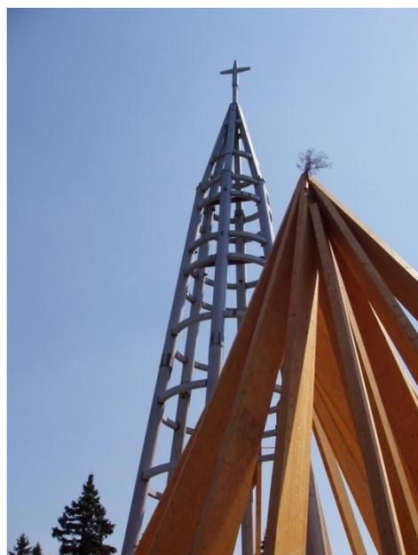
Slika 128: Spoj nosilcev v slemenu
