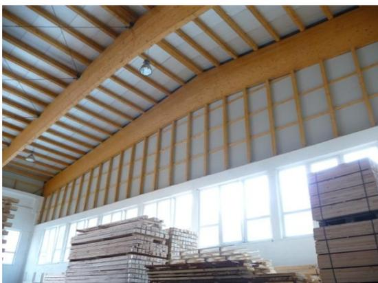
Slika 164: Čelni lepljeni lamelirani nosilci
