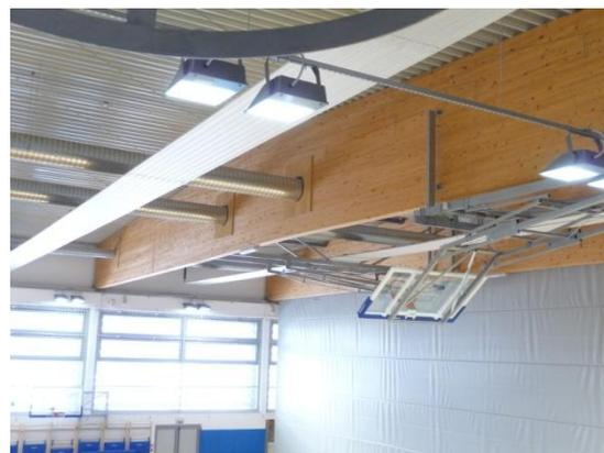
Slika 92: Nosilec z izvrtinami za prezračevanje
