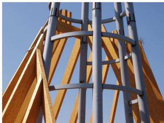
Slika 126: Spoj jeklene in lesene konstrukcije
