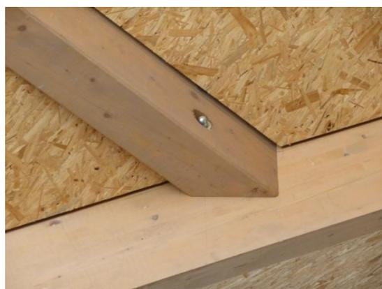
Slika 122: Spajanje lepljenih nosilcev
