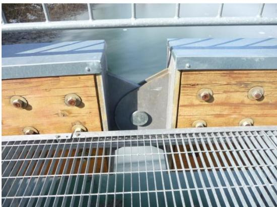
Slika 150: Jekleni spoj med nosilcema
