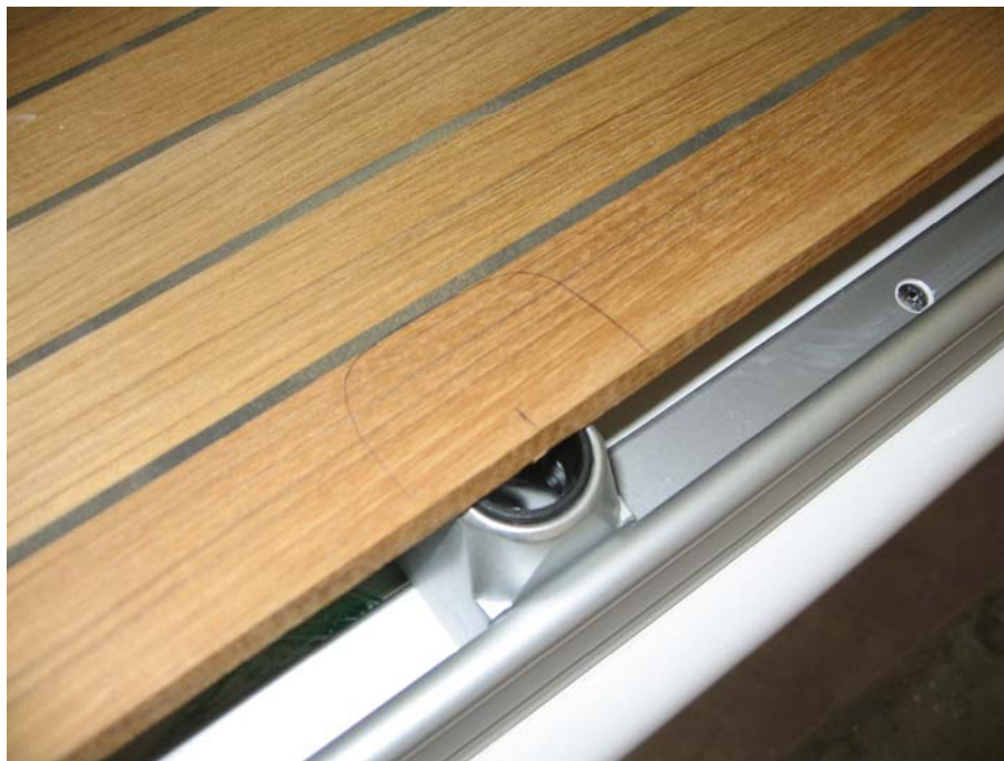
Slika 36: Zarisovanje odprtin za stebričke ograjice
