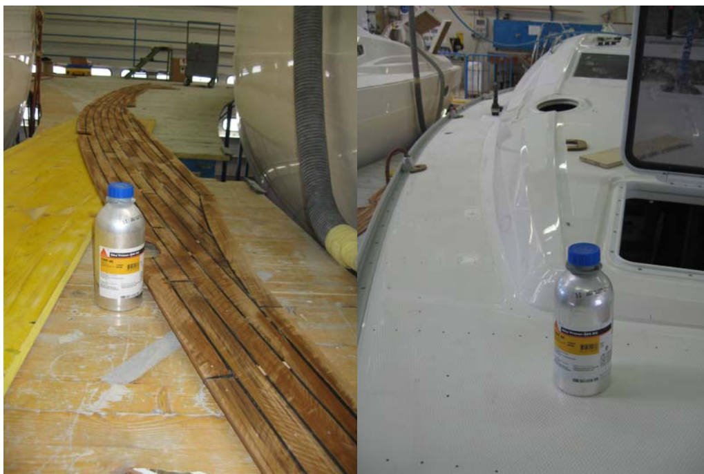
Slika 39: Obloga in paluba premazana z osnovnim premazom
