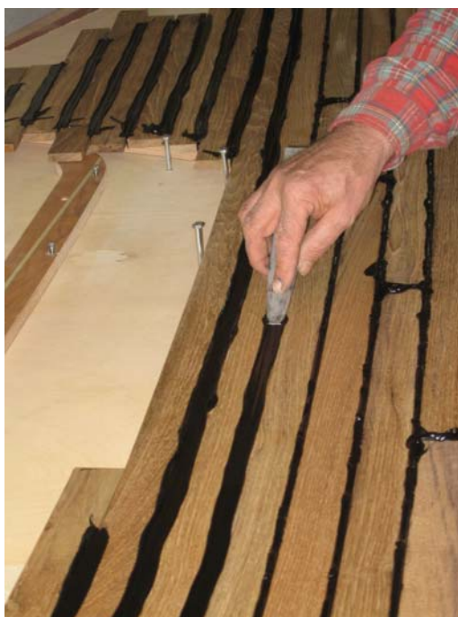
Slika 27: Izravnava tesnilne mase v špranjah
