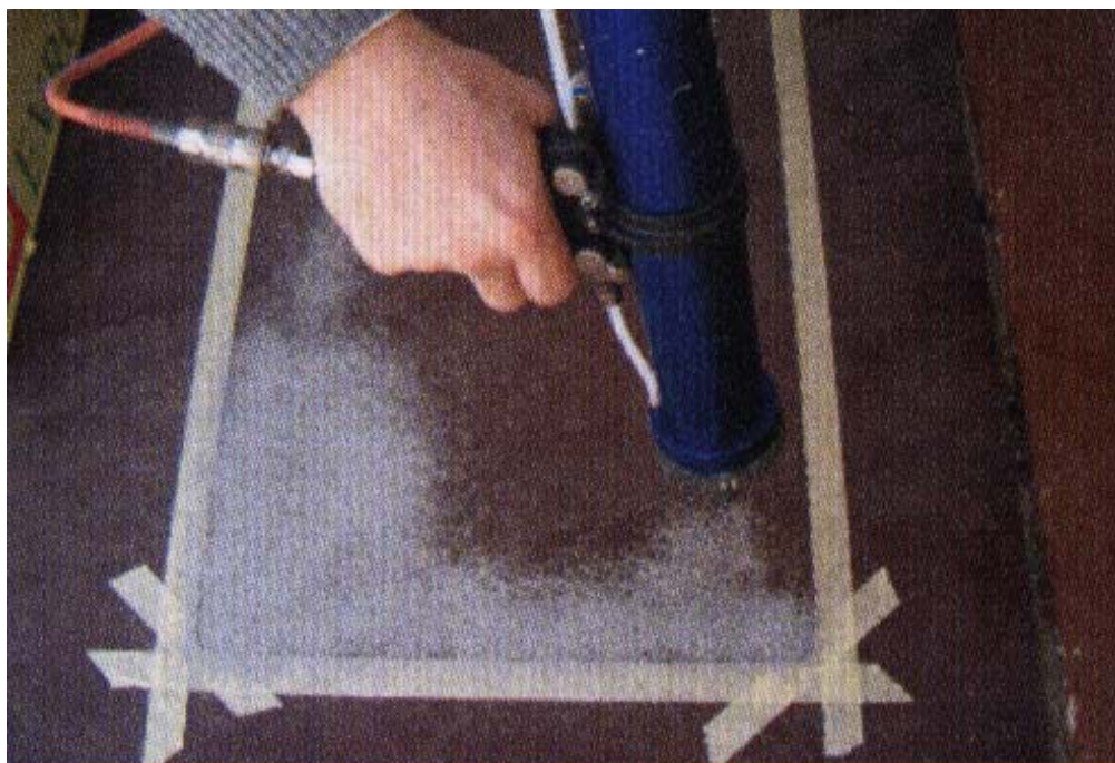
Slika 1: Brizganje palube s MS polimeri (Peteh, 2004)
