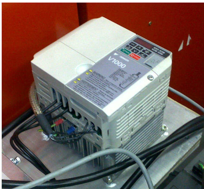
Slika 28: Frekvenčni pretvornik Omron V1000
