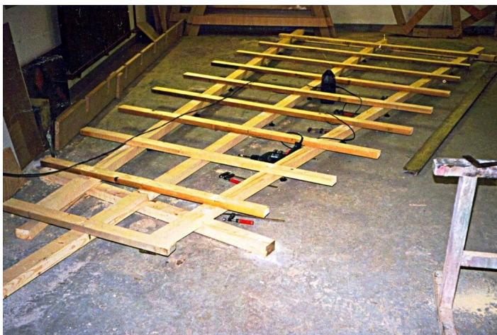
Slika 51: Postavitev temelja za gradnjo modela trupa
