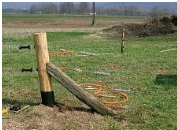
Slika 6: Napenjalni kol mora biti dobro podprt, da ga pri napenjanju žic ne izrujemo iz tal (foto: F. Čemažar)
