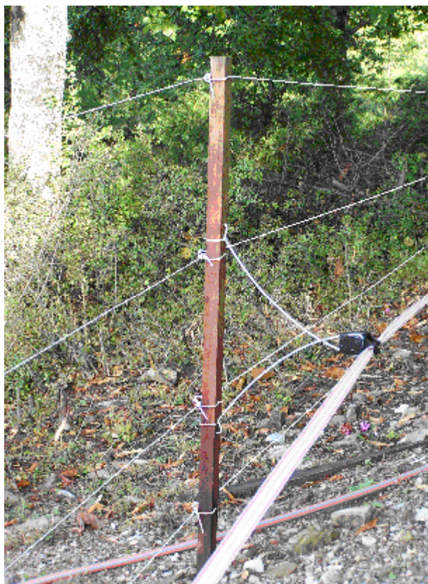
Slika 14: Štirižična stalna elektroograja ojačana z elektrotrakom na tisti strani, kjer obstaja nevarnost prehoda zveri (foto: T. Vidrih)
