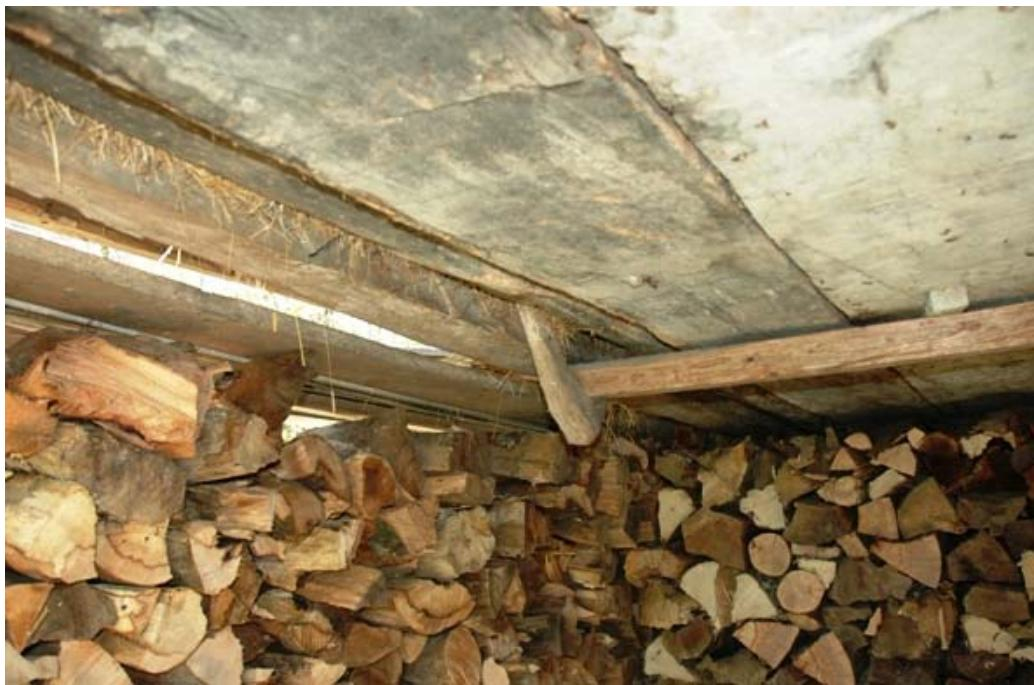
Slika 10: Enostavna konstrukcijska rešitev za nosilni element zgornjega osrednjega hodnika
