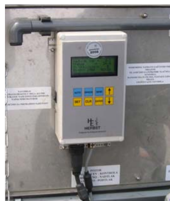
Slika 24: Ekran kjer se izpišejo podatki o delovanju črpalke (foto: D. Danijel)
