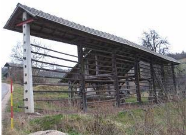
Slika 15: Štravsov enojni stegnjeni kozolec s plaščem
