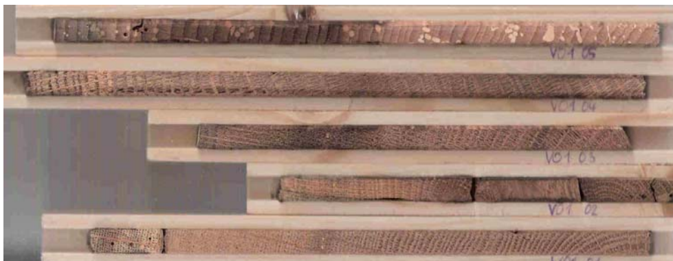
Slika 25: Izvrtki iz objekta Vicov pod
