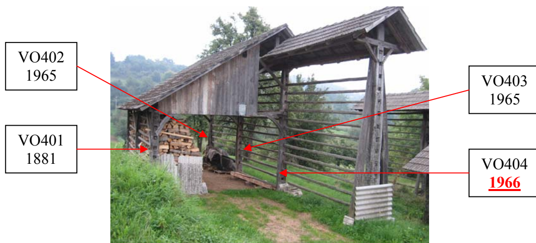
Slika 32: Majacov enojni stegnjeni kozolec s plaščem z označenimi mesti odvzema izvrtkov
