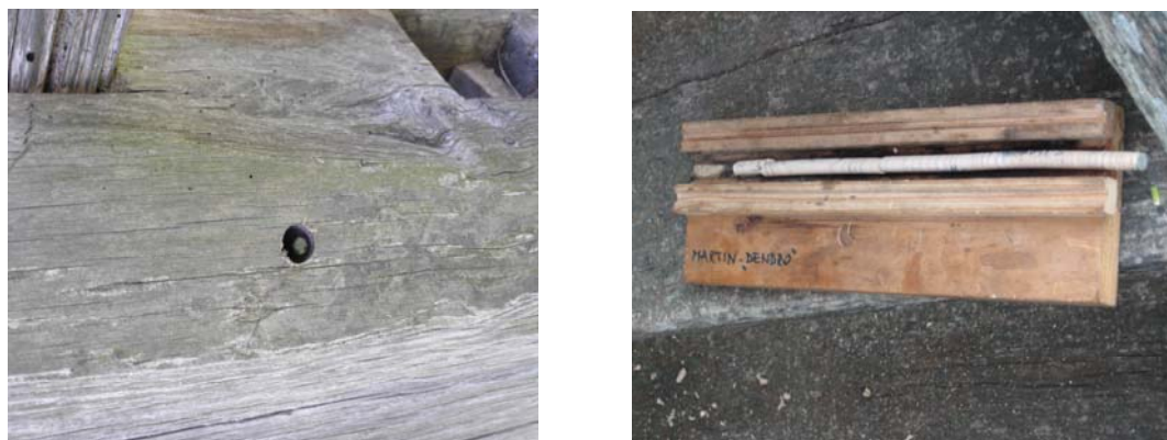
Slika 20: Izvrtek v izvrtini - levo, izgled izvrtka - desno
