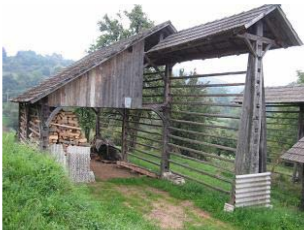
Slika 14: Majacov enojni stegnjeni kozolec s plaščem
