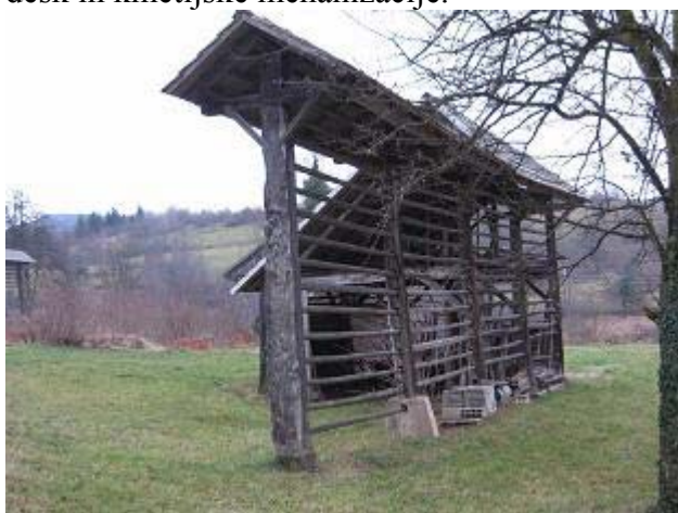
Slika 17: Juretov enojni stegnjeni kozolec s plaščem
