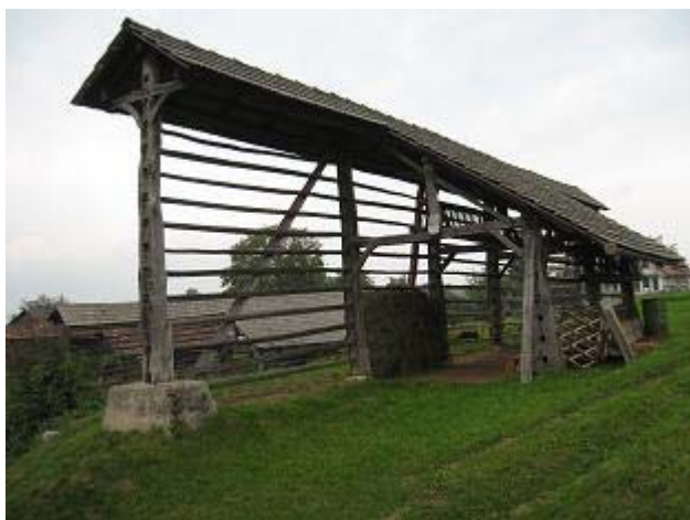
Slika 13: Pipanov enojni stegnjeni kozolec s plaščem
