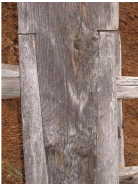
Slika 12: Zamenjan spodnji del stebra
