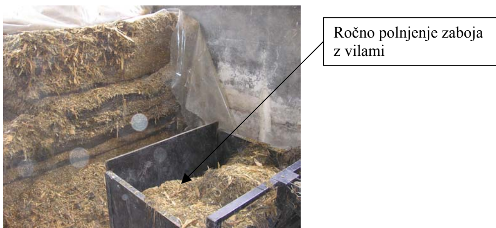
Slika 12: Polnjenje zaboja in poškodovana silosna stena (foto: Andrej Dornik).
