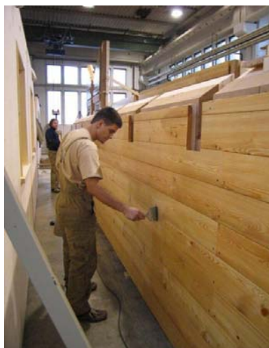
Slika 5: Nanašanje zaščitnih pripravkov s premazovanjem (Humar, 2005)
