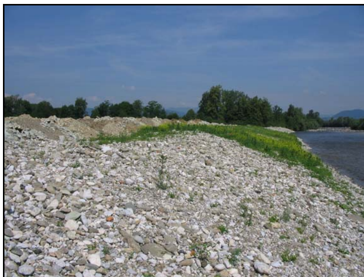
Slika 11: Na novo sanirana brežina, ki jo je potrebno pogozditi (foto: Fonda)
