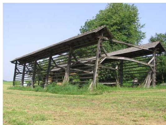
Žagarjev kozolec je dvojni stegnjeni kozolec na pet parov oken in plaščem med četrtim in petim stebrom.
