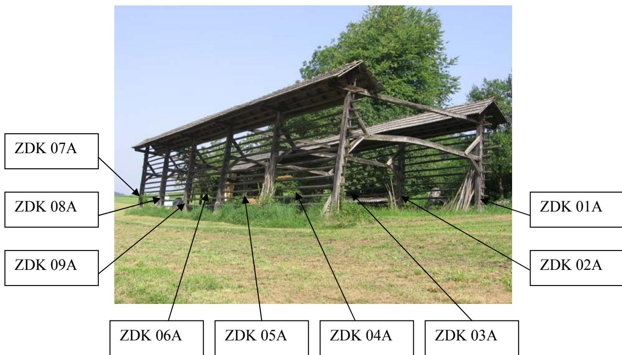
Slika 19: Žagarjev kozolec z označenimi mesti odvzema vzorcev
