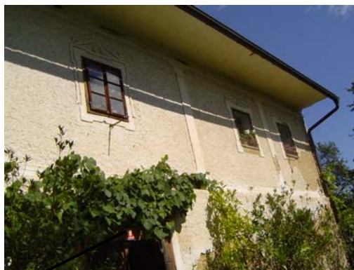
Slika 32: Fasada in vhod hiše
