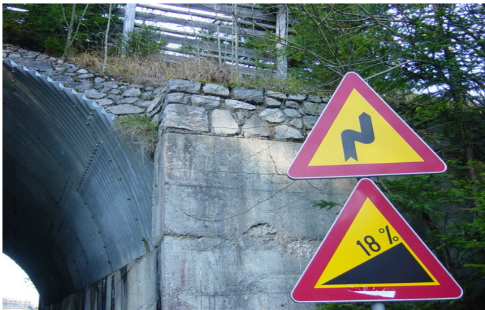
Slika 4: Način gradnje mostu preko ceste na Zatrniku za potrebe smučišča
