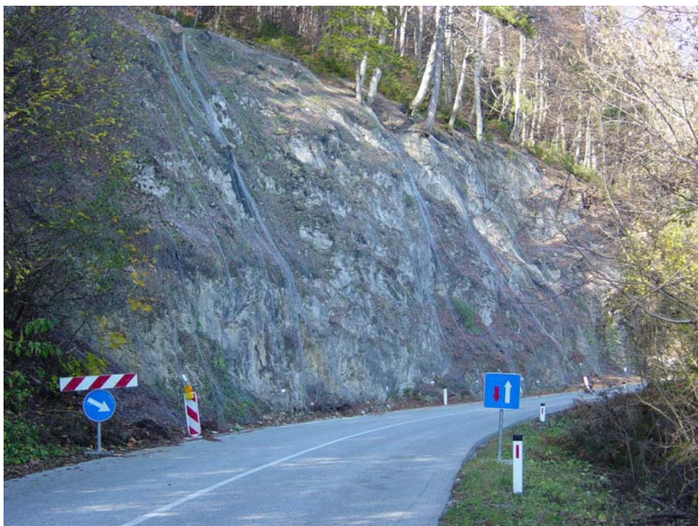
Slika 9: Zavarovanje brežin
