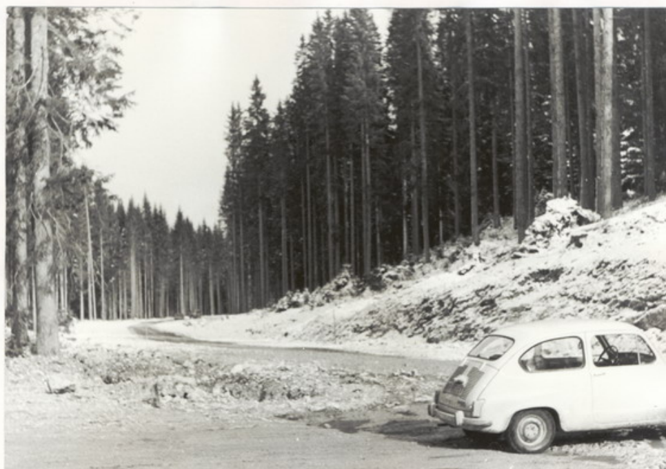
Slika 7 in 8: Gradnja ceste od Mrzlega studenca do oddelka 57 v smeri Zatrnika
