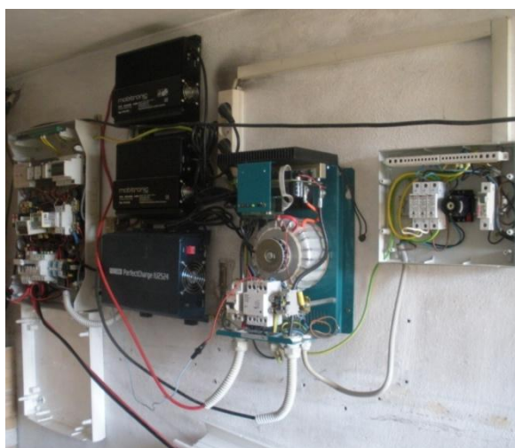
Slika 37: Električni agregat (levo) in razsmerniki elektrike (desno) (foto: Andreja Jeraj)
