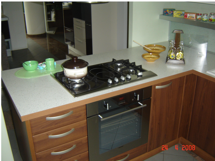
Slika 6: Delovna plošča izdelana iz iverne plošče oblepljene z laminatom
