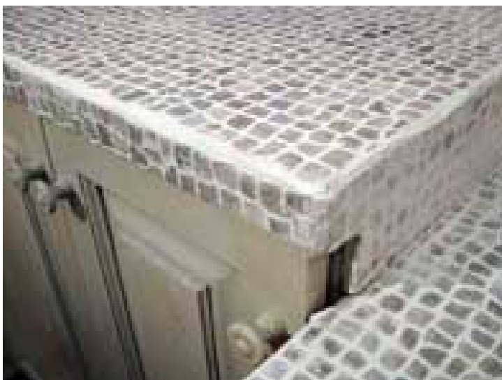
Slika 3: Delovna plošča iz keramičnih ploščic
