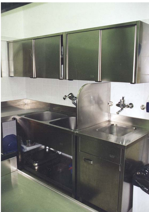
Slika 5: Delovna plošča iz nerjaveče pločevine
