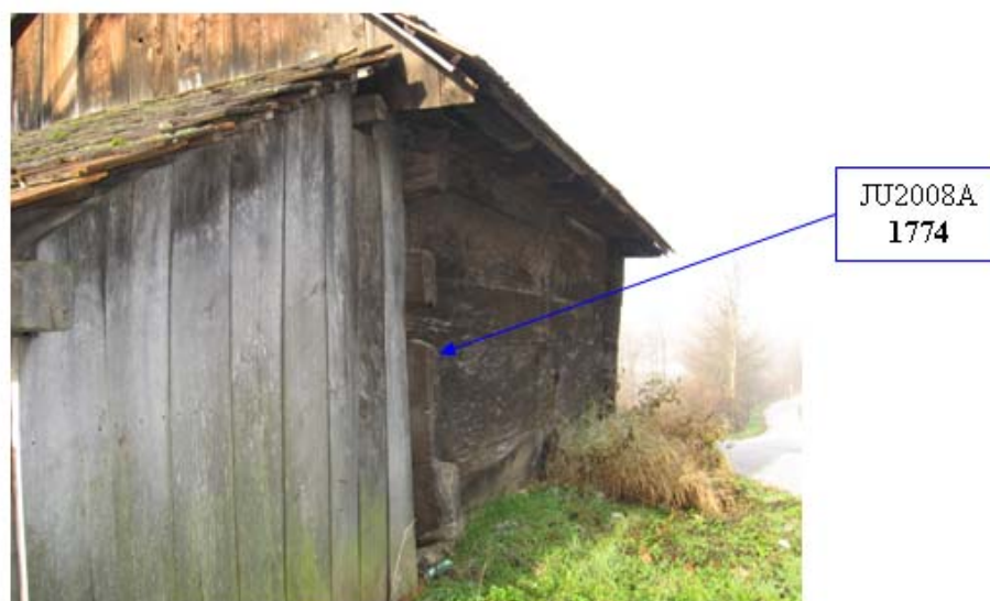
Slika 29: Vinski hram - mesta odvzemov in šifre izvrtkov (zadnji del).
