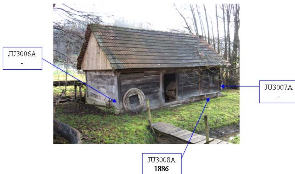
Slika 31: Rožmanov mlin - mesta odvzema in šifre izvrtkov (zunanji del).
