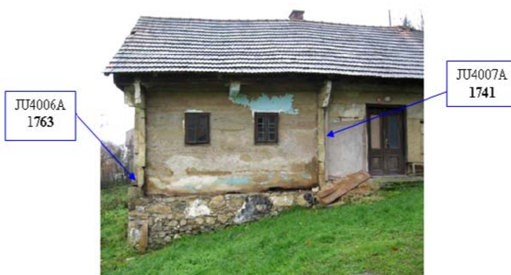
Slika 35: Lesena hiša - mesta odvzema izvrtkov in šifre (prednji del).
