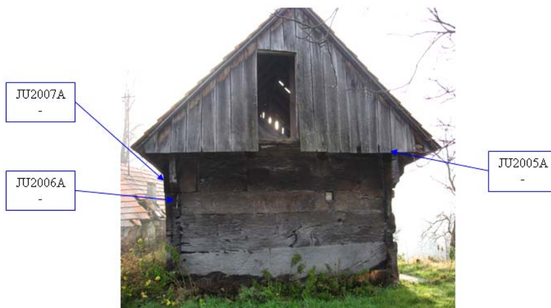
Slika 28: Vinski hram - mesto odvzema in šifre izvrtkov (pogled s ceste).
