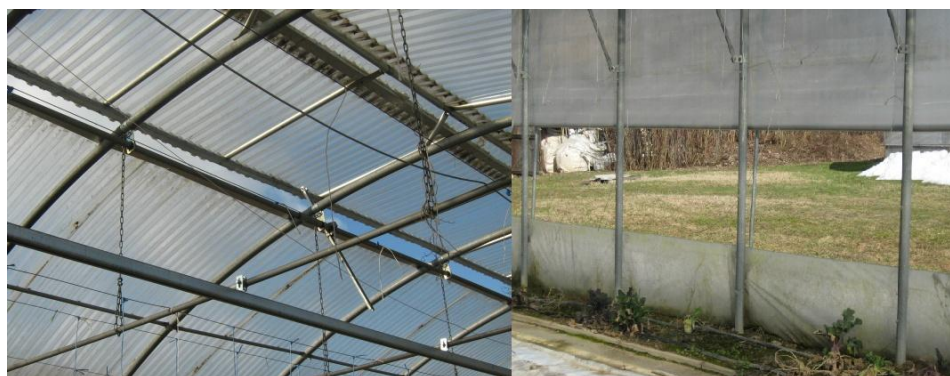
Slika 11: Strešno in bočno zračenje
