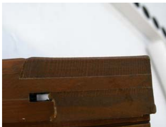
Slika 46: Poškodba na površini domačega macesna (zgoraj levo), nepravilno zaščiten spoj (zgoraj desno), dimenzijske spremembe vzorcev (spodaj levo)
