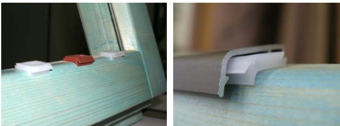
Slika 11: Plastični distančniki med lesom in aluminijem
