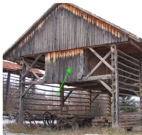
Slika 143: Severozahodni vogal Jurjevega topolarja z mrežasto brano - levo
