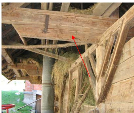
Slika 141: Nadstrešek severovzhodne strani Plantanovega poda z obokano roko - levo
