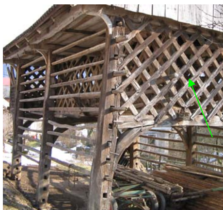
Slika 143: Severozahodni vogal Jurjevega topolarja z mrežasto brano - levo
