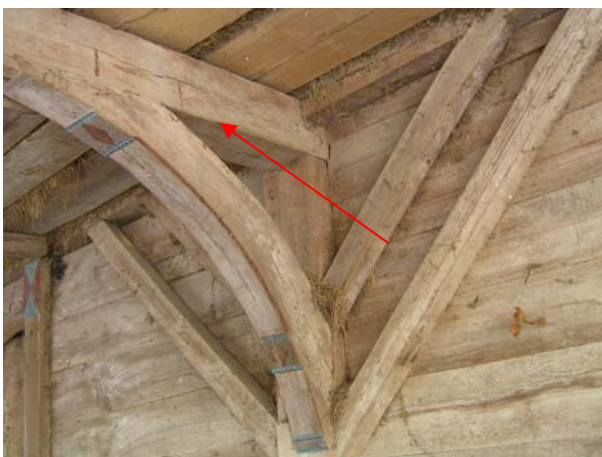
Slika 141: Nadstrešek severovzhodne strani Plantanovega poda z obokano roko - levo
