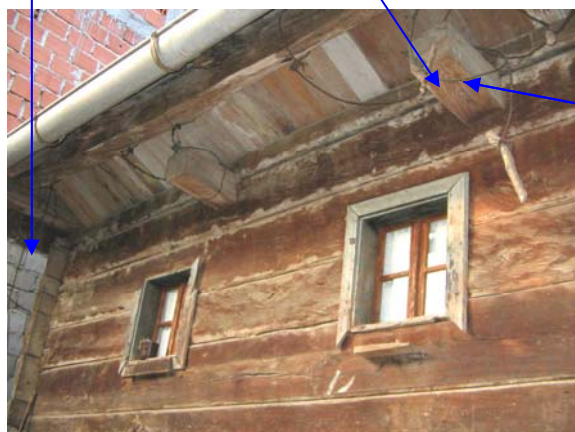
Slika 99: Nadstrešek zahodnega dela Milanove hiše - levo
