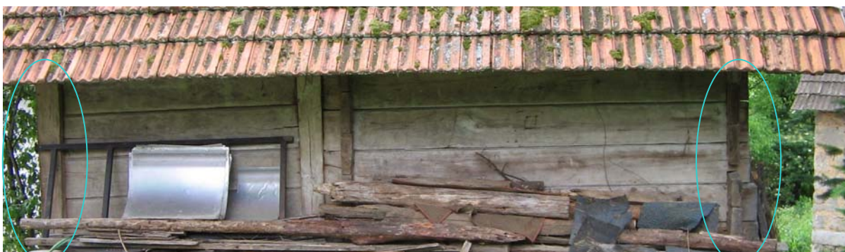
Slika 136: Severozahodni del Pungarterjeve kašče
