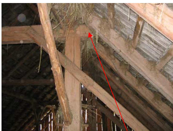
Slika 118: Nosilna prečna gred ostrešja, jugozahodne strani Plantanovega poda - levo
