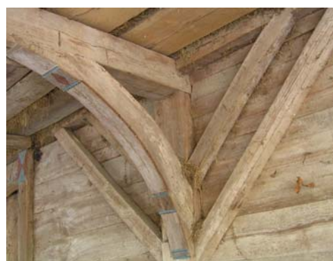
Slika 113: Obokana roka nadstreška severozahodne strani Plantanovega poda - desno.
