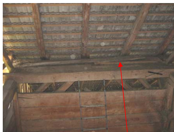
Slika 118: Nosilna prečna gred ostrešja, jugozahodne strani Plantanovega poda - levo
