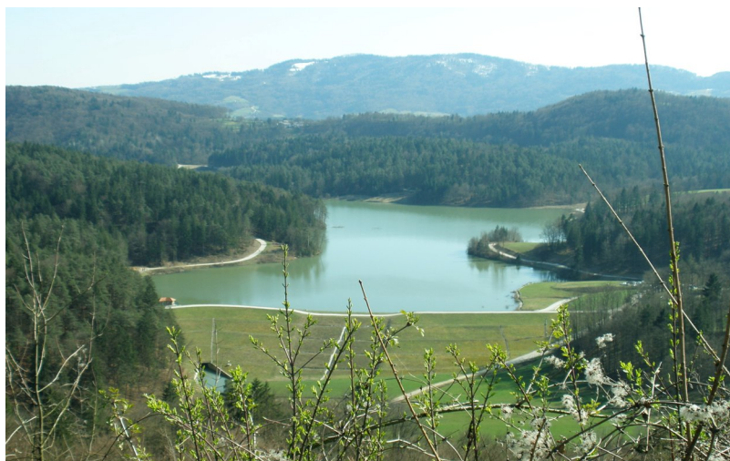
Slika 1: Zadrževalnik visokih voda Drtijiščica.
