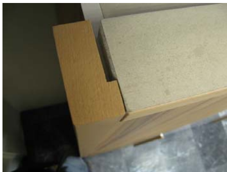
Slika 34: Spoj pokončnika in prečnika venca pri garderobni omari (slikano od zgoraj navzdol)
