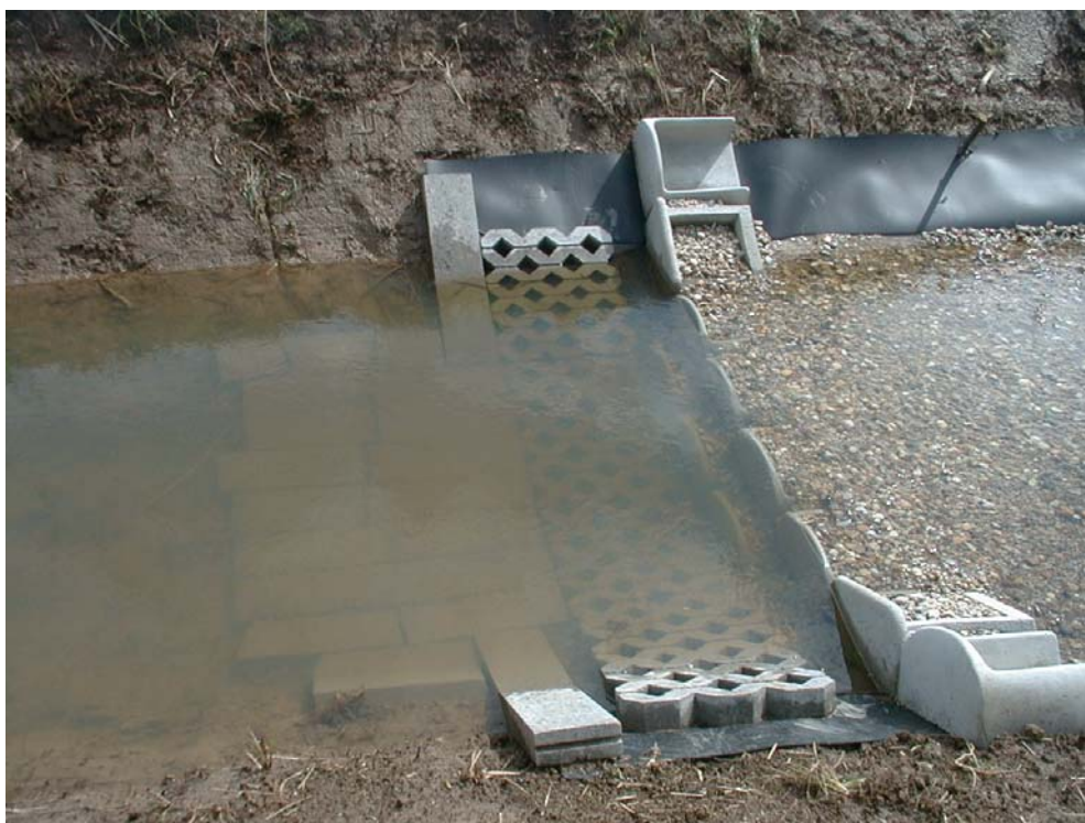
Slika 7: Dotok ERM jarka pri Lešnici, narejen iz škarpnikov
