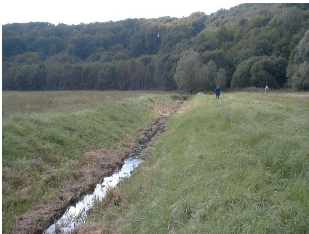
Slika 6: Osuševalni jarek pri Lešnici pred izgradnjo ERM grede
