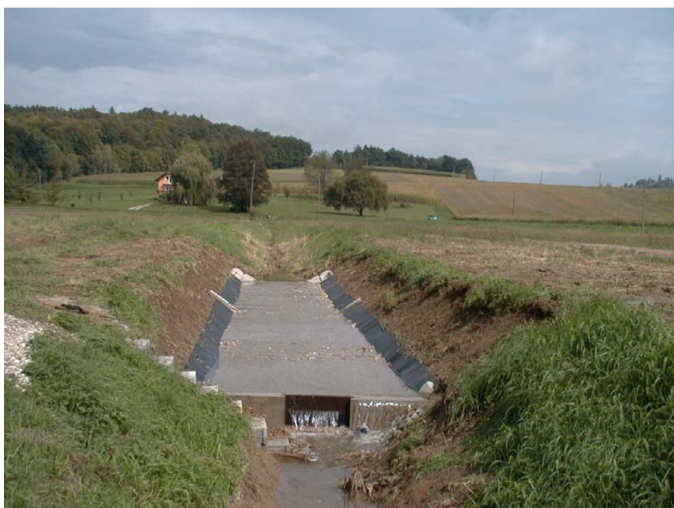
Slika 8: ERM jarek pri Lešnici takoj po izgradnji, pred zasaditvijo z navadnim trstom ( Phragmites australis )
