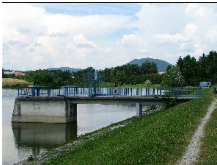
Slika 3: Zapornica - prepust na pregradi Trnava, preko katere nadzorujejo gladino jezera (foto: Mojca Maze)
