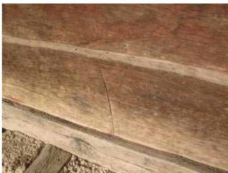
Slika 67: Stene iz žaganih plohov iz bukovine
