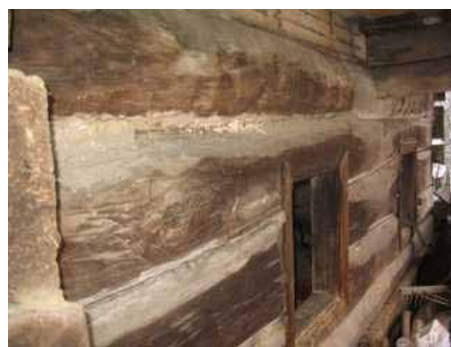
Slika 34: Stene »hiše«, (a) tesana bruna na severni strani hiše, (b) tesana bruna na južni strani hiše
