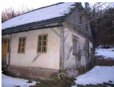
Slika 61: Dvojno okno, izdelano iz lesa smrekovine
