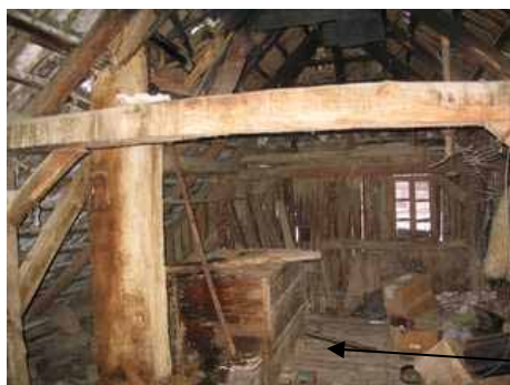
Slika 58: Ostrešje in strop iz polovičnih brun
