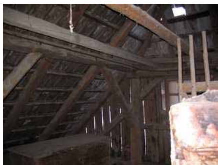
Slika 59: Ostešje, (a) ostešje v predelu čopa, (b) ostešje s podpornim stebrom nad vežo
