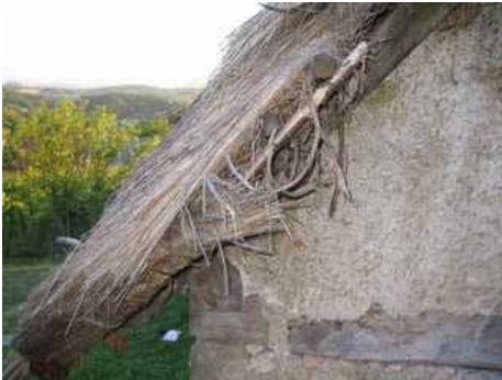
Slika 5: Slamnata streha s srobotino vezane preklice - levo
