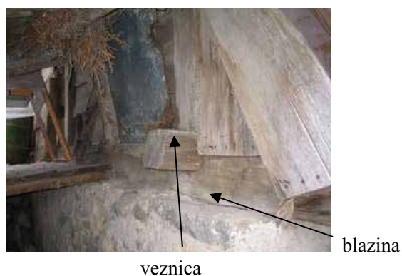
Slika 33: Detajli Hribarjeve hiše, (a) spoj veznice in blazine, (b) blazina in veznica, spoj veznice in blazine
