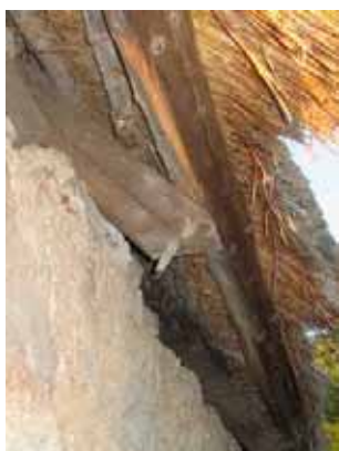
Slika 9: S klini pritrjena kapna letev na špirovce - levo
