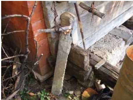
Slika 66: Spoj talnih tramov (blazine in veznice)
