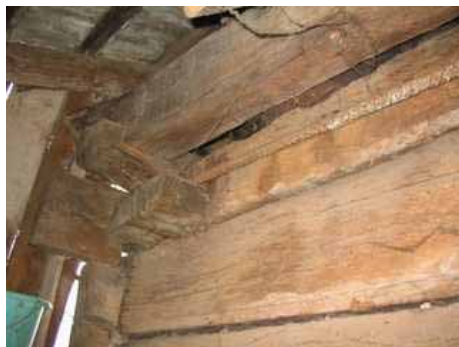
Slika 34: Stene »hiše«, (a) tesana bruna na severni strani hiše, (b) tesana bruna na južni strani hiše
