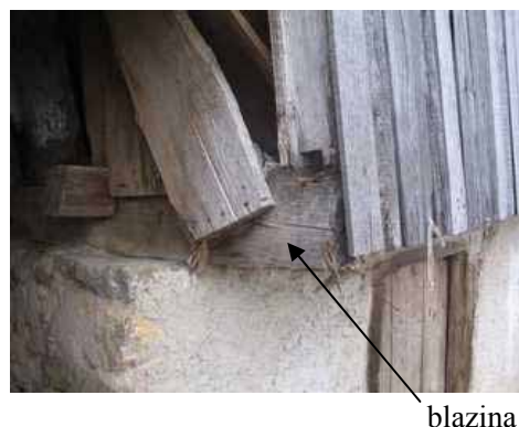
Slika 33: Detajli Hribarjeve hiše, (a) spoj veznice in blazine, (b) blazina in veznica, spoj veznice in blazine
