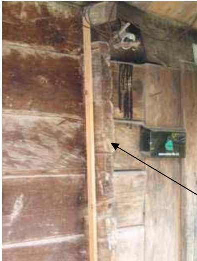
Slika 72: Vez na križ med zunanjo in notranjo pregradno steno
