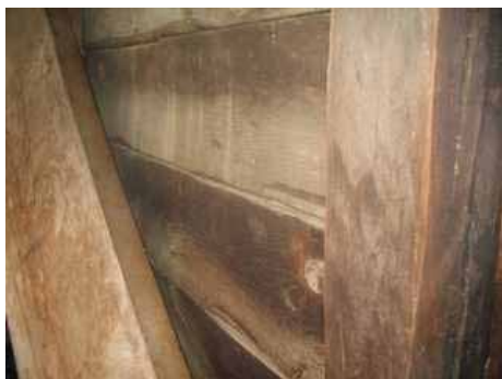
Slika 36: Stene črne kuhinje, (a) stena iz žaganih plohov in vmesni steber, (b) stena na zunanji strani, (c) stena in vogalni steber, (d) skica vezi na križ
