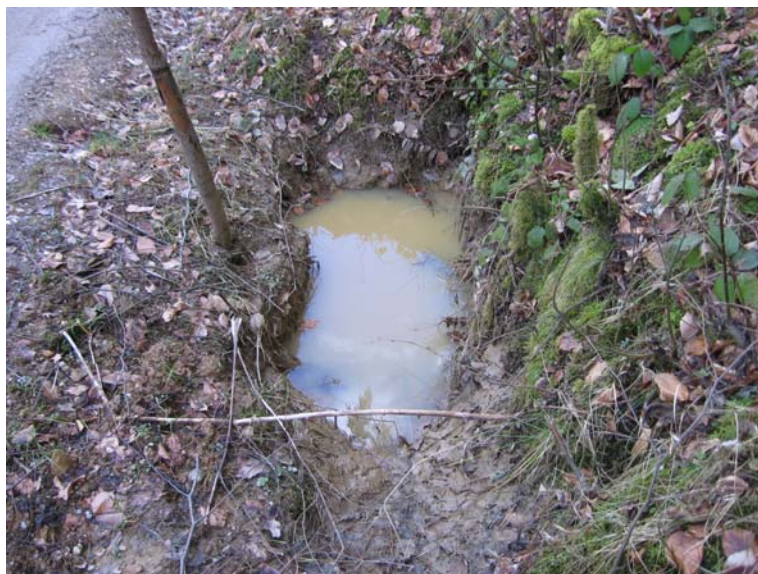
Slika 22: Zasuta cev zaradi neurejenega vtočnega jaška
