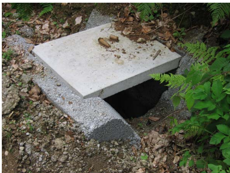
Slika 8: Pravilno urejen vtočni jašek z pokrovom
